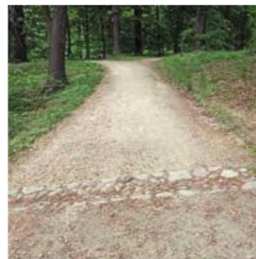
MZK okrový s kamenným příčným žlabem
